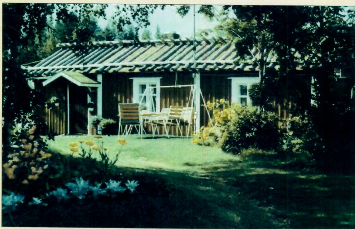
Pramilan torpan pihapiiri on huolella hoidettu. Rakennuksen katolle vuonna 1980 suoritettun remontin yhteydessä asennetut mäntypuiset malot poistettiin myöhemmin Museoviraston ohjeiden mukaisesti. Huopakaton alle jätetty alkuperäinen tuohikatto on ladottu 30 x 30 senttimetrin kokoisista tuohista samalla tavoin kuin pärekatto. Alkuperäistä kattoa voi tarkastella lähemmin kapuamalla rakennuksen ullakolle eteisessä olevan kattoluukun kautta. Ympäristöministeriö vahvisti Pramilan torpan suojelun 16.12.1998.
